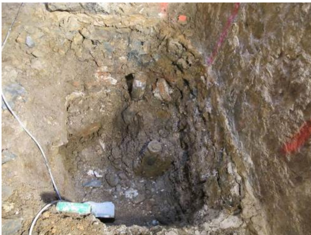
Foto 27: Tasques de demolició del ciment adherit als micropilotatges
