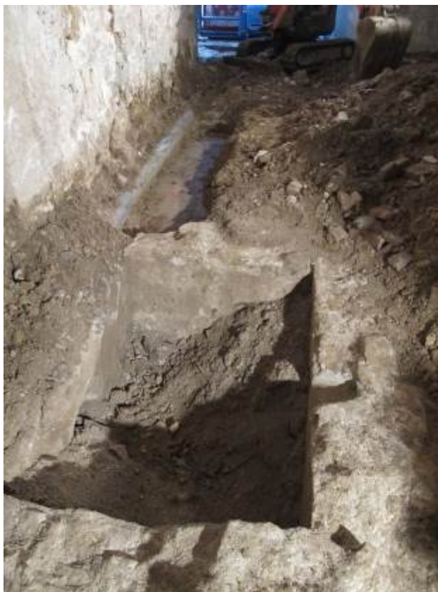
Foto 19: Dipòsit UE 18 i paviment UE 20
