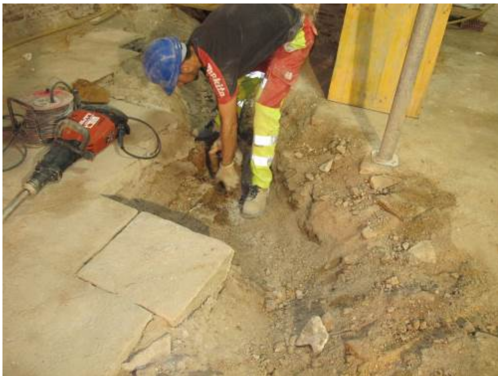
Foto 135: Demolició del mur UE 100
