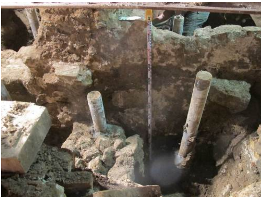
Foto 62: Mur UE 88 i mur UE 89
