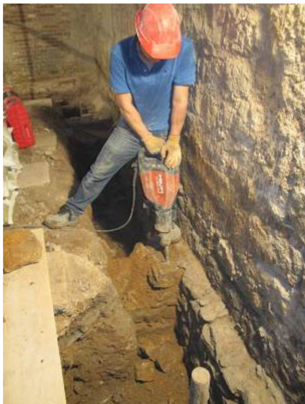
Foto 129: Demolició del mur 64
