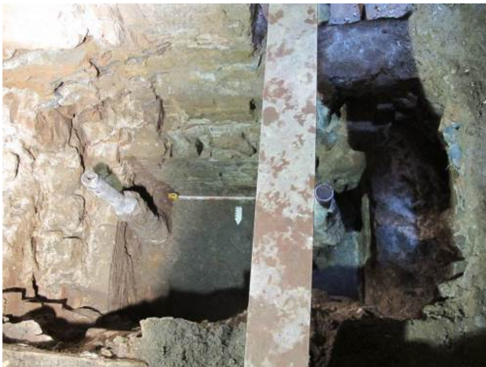
Foto 49: Paviment del dipòsit UE 78
