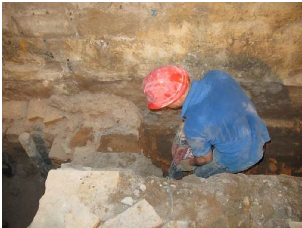
Foto 94: Demolició del dipòsit
