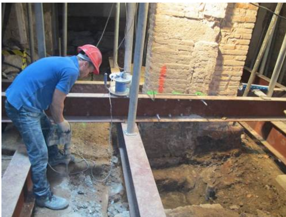
Foto 41: Demolició del paviment actual
