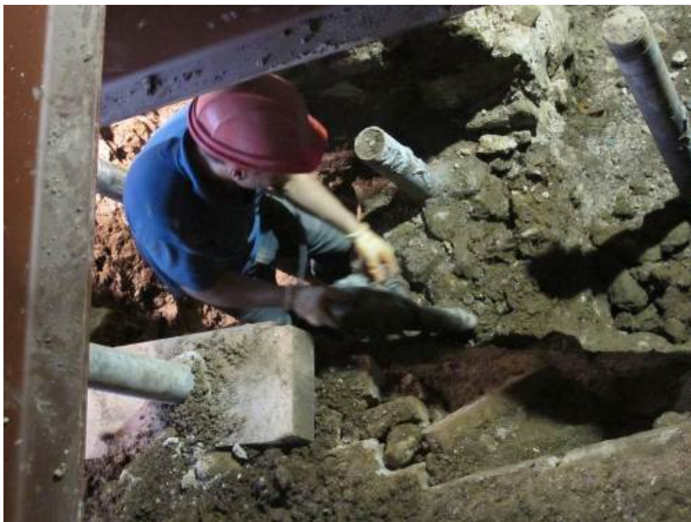
Foto 71: Demolició del mur 88
