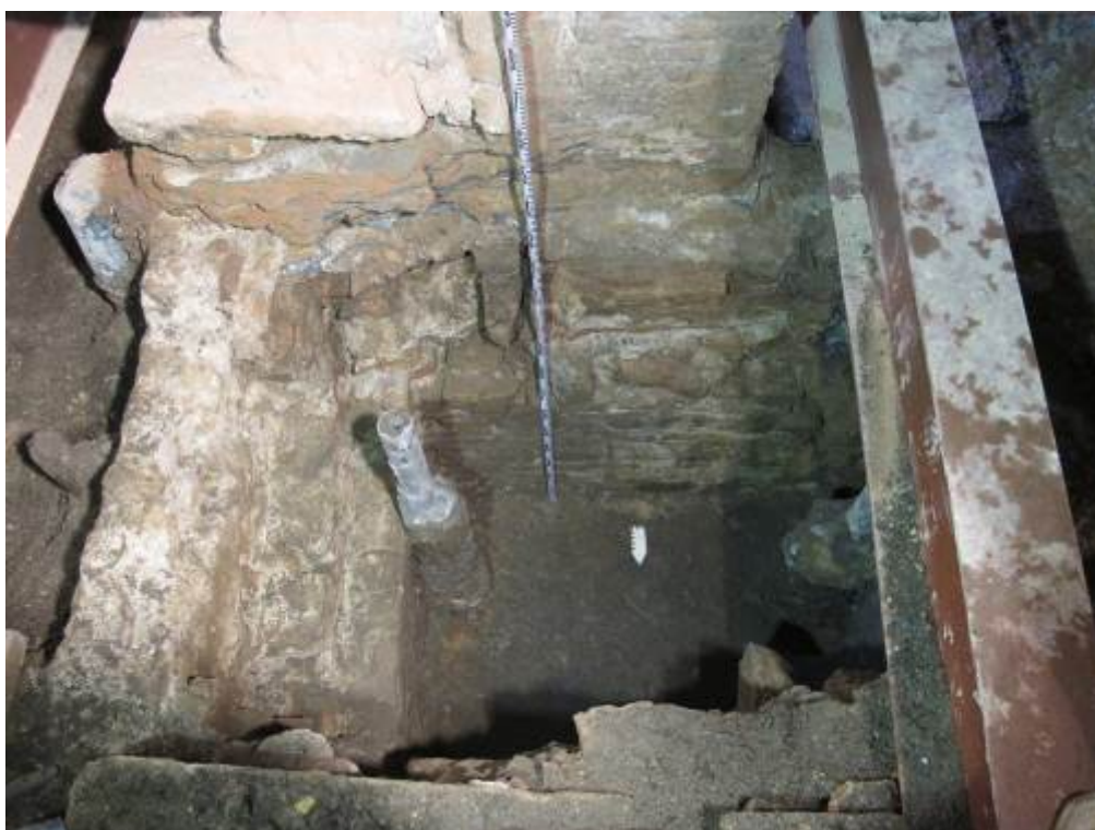
Foto 50: Paviment del dipòsit UE 78
