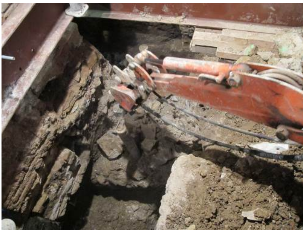
Foto 70: Demolició dels murs 83 i 89
